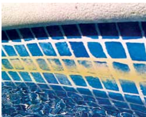
Corrosión e incrustación causada por un desbalance químico por valores de Dureza y Alcalinidad bajas o elevadas
