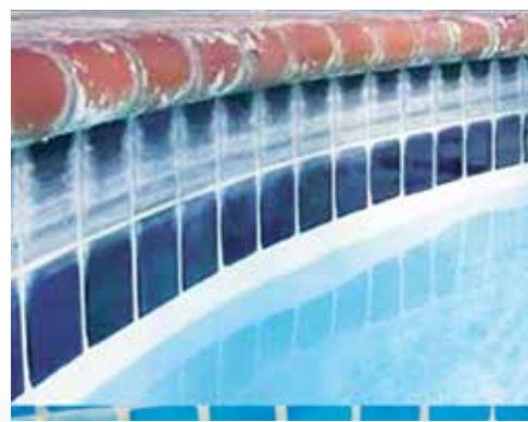
Corrosión e incrustación causada por un desbalance químico por valores de Dureza y Alcalinidad bajas o elevadas
