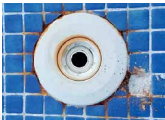
Corrosión e incrustación causada por un desbalance químico por valores de Dureza y Alcalinidad bajas o elevadas
